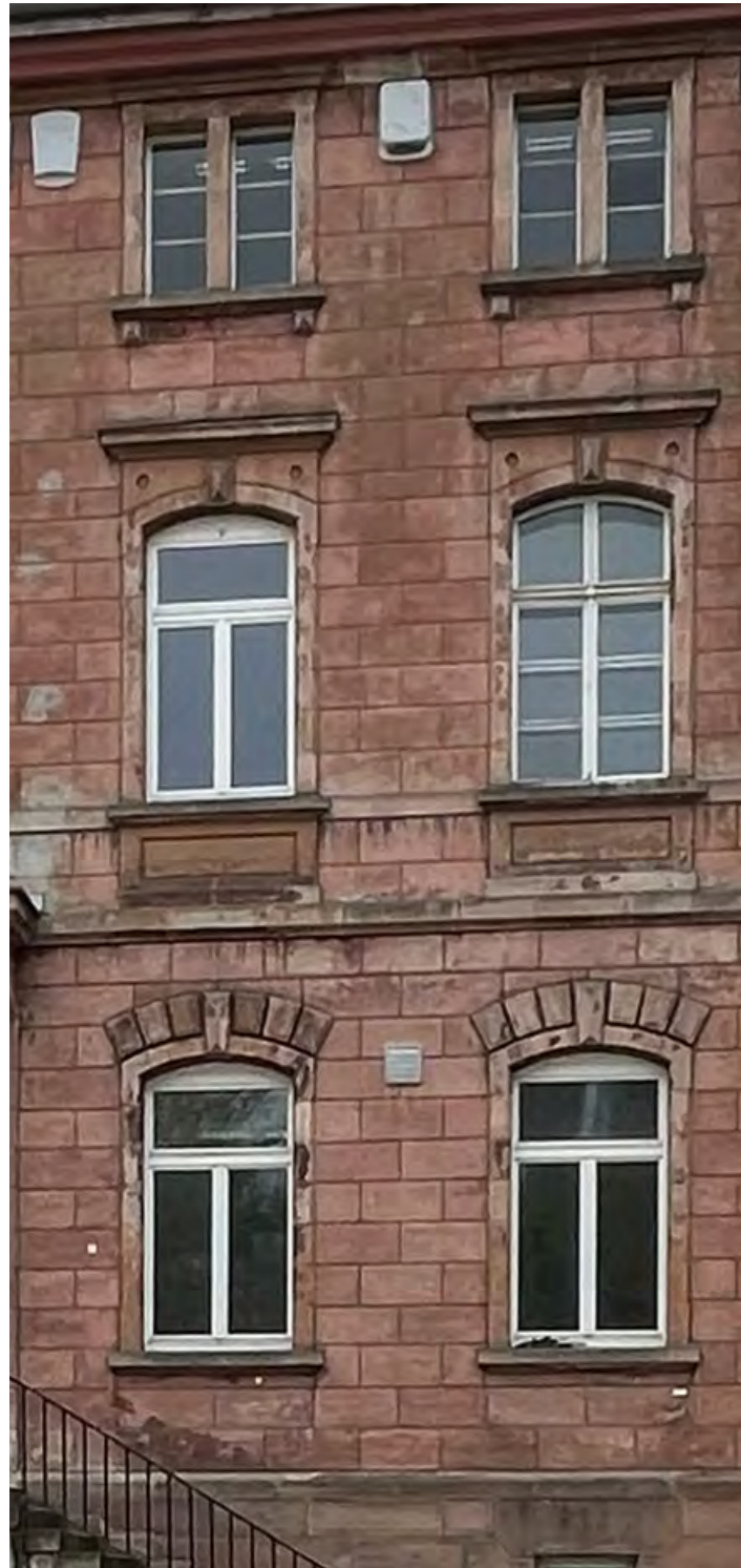
Fassadenausschnitt Mittelrisalit (Nordseite). Neben dem bauzeitlichen vierflügligen Kreuzstockfenster mit Sprossenteilung sind auch neuzeitliche zweiflüglige Fenster erkennbar.
