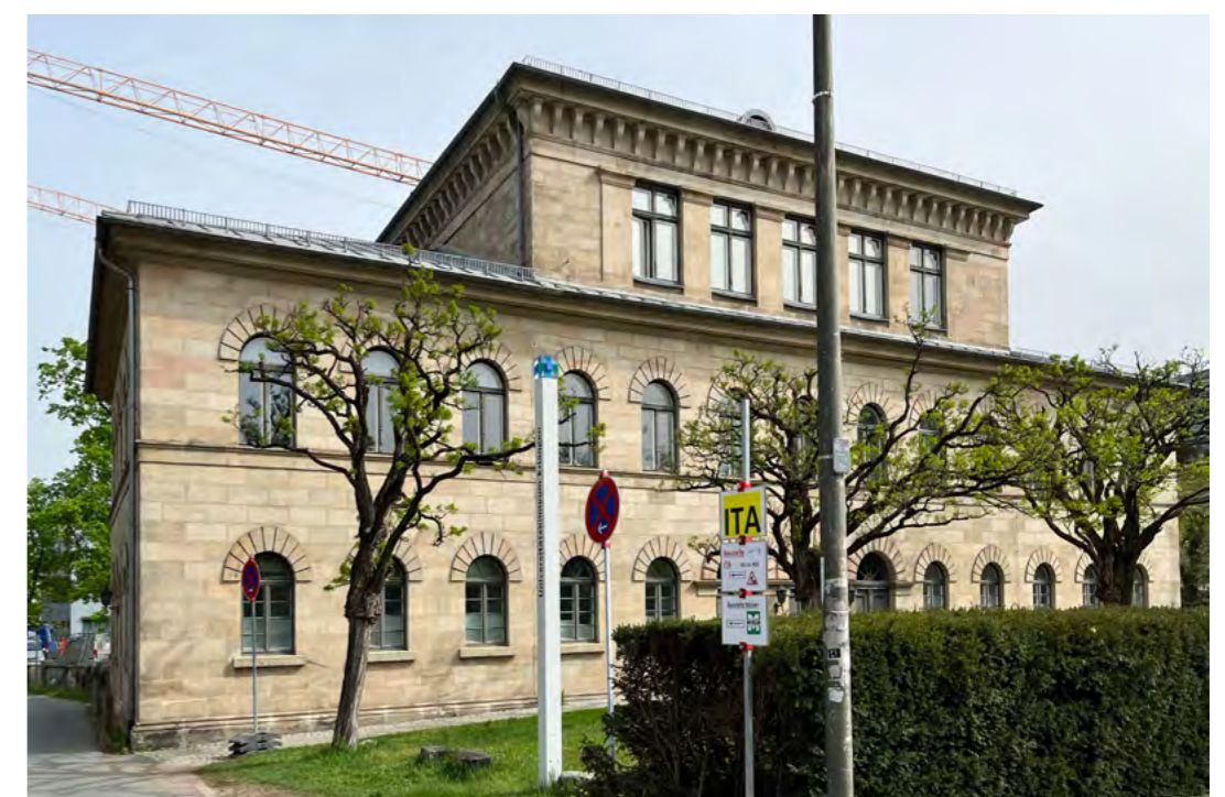
Oben: Heil- und Pflegeanstalt Erlangen, Blick auf den Verwaltungsbau Maximiliansplatz. Die Aufnahme zeigt die ehemalige panoptische Anlage vor dem Abbruch Ende der 1970er Jahre (StadtAE, VIII.9153.N.3/6).
