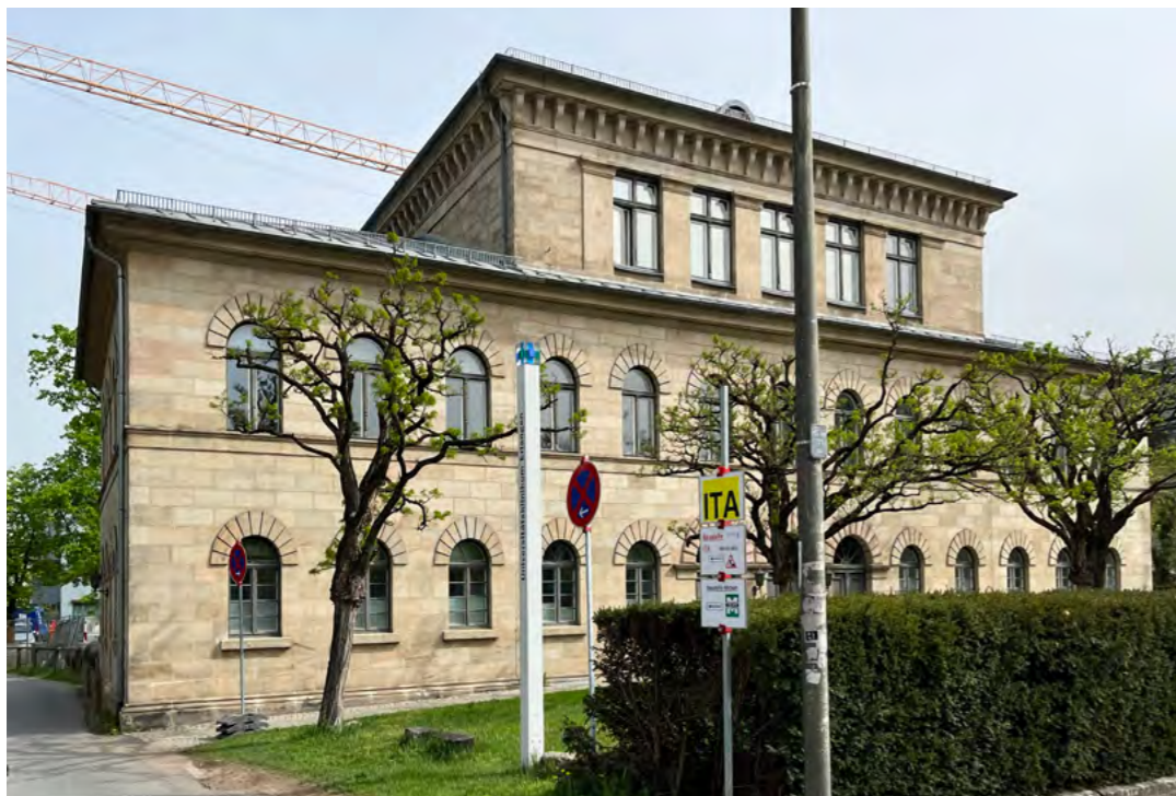
Oben: Nordansicht der Schwabachanlage 10 mit Außentreppe und Eingangsportal
