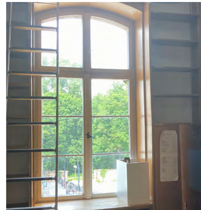
Oben: Detailansicht des bauzeitlichen Fensters im 1. OG des Westflügels (Bibliothek) mit horizontalen Fenstersprossen
