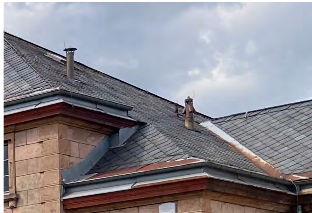
Oben: Blick auf das südwestliche Dach. Die gleichförmige Schuppendeckung aus Schiefer ist sehr gut erkennbar.
