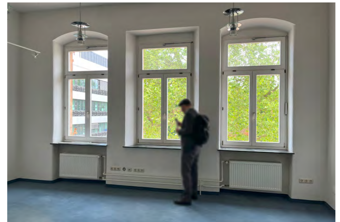
Oben: Großer Bibliotheksraum 01.024 im Westflügel mit Einbaumöbeln (vermutlich Nachkriegszeit). Der Raum ist noch mit historischen Sprossenfenstern ausgestattet. Unten: Raum 01.211 im Ostflügel. Gut zu erkennen ist das nicht bauzeitliche, mittige Fenster. Über den Zeitpunkt und die Gründe des Einbaus des dritten Fensters ist aktuell nichts bekannt.
