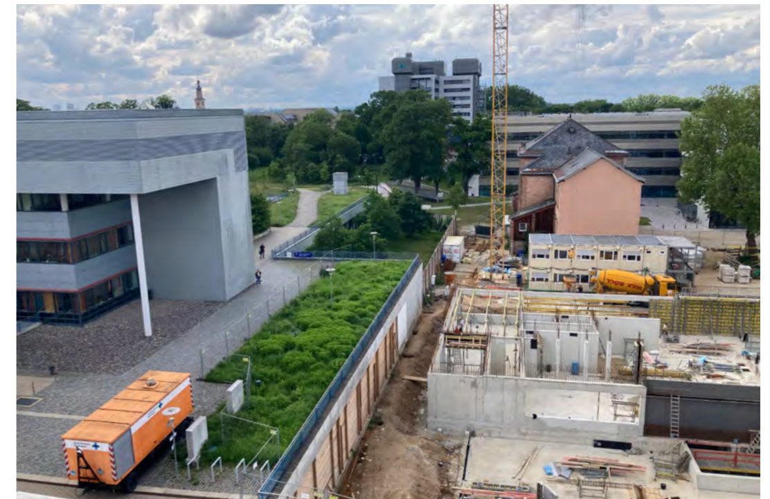
Oben: Südansicht der Schwabachanlage 10. Deutlich zu erkennen sind die Schnitte durch die westliche und südliche Fensterachse.
