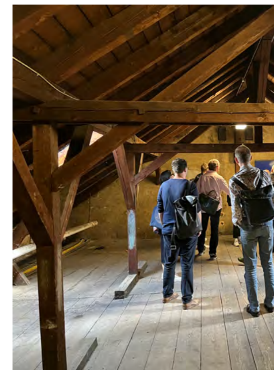
Untere Reihe: Dachstuhl der Seitenflügel, Pfettendachstuhl. Fotos Ist-Zustand und Schnittdarstellung Westflügel.
