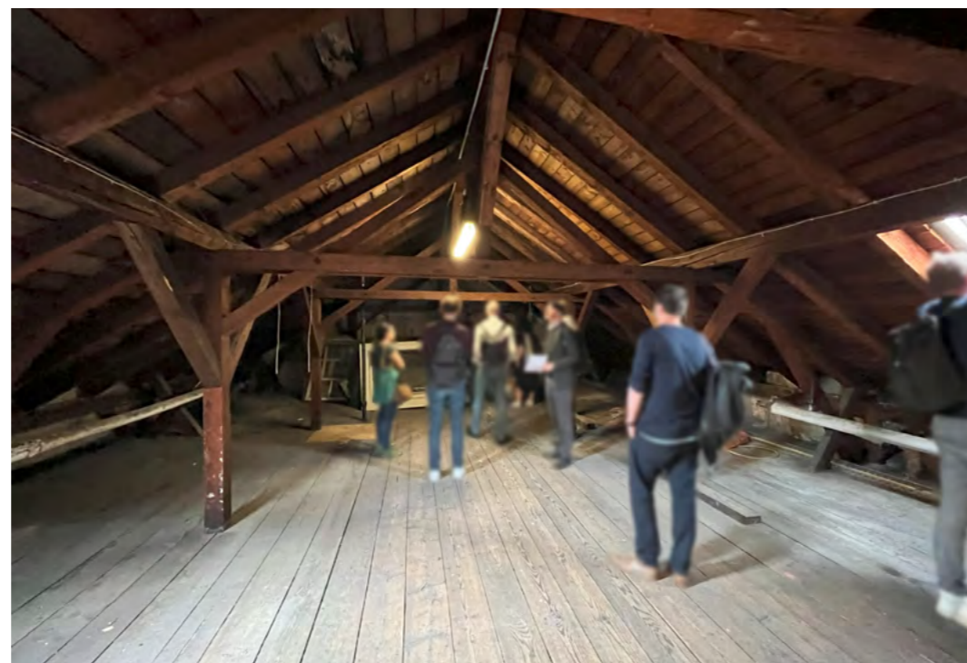
Obere Reihe: Dachstuhl Mittelbau, Walmdach. Fotos Ist-Zustand und Schnittdarstellung.
